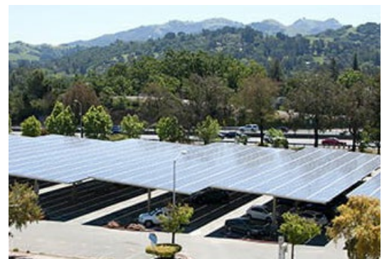
Source: BEI Construction Inc.
